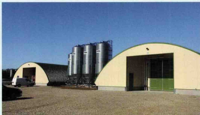
Les éleveurs disposent de 5 200 m 2 de poulaillers répartis en quatre bâtiments. Une centaine de mètres sépare la chaufferie biomasse de chaque poulailler, qui est équipé d'un petit réseau de distribution.
